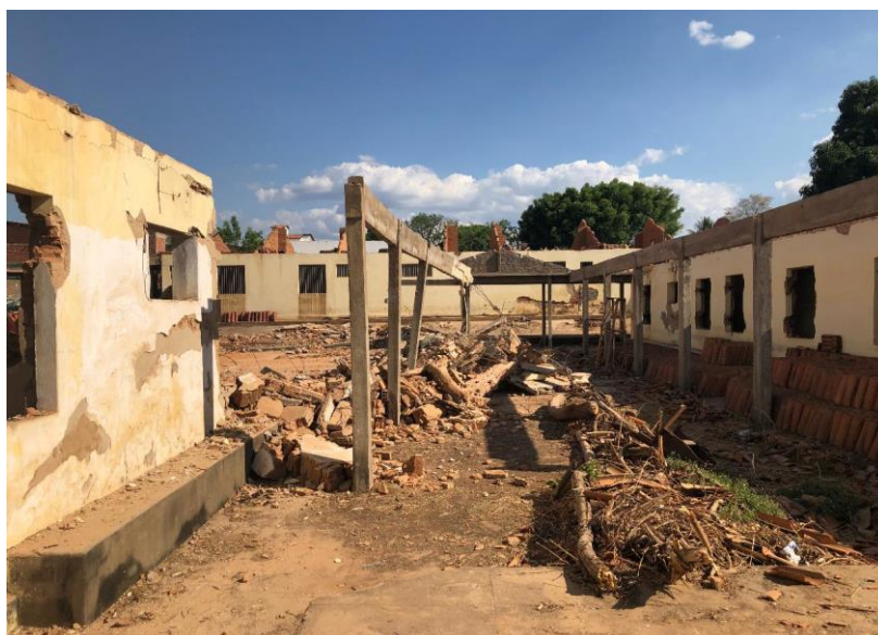
Figura 3: Casa de Saúde Santa Teresa em demolição.
