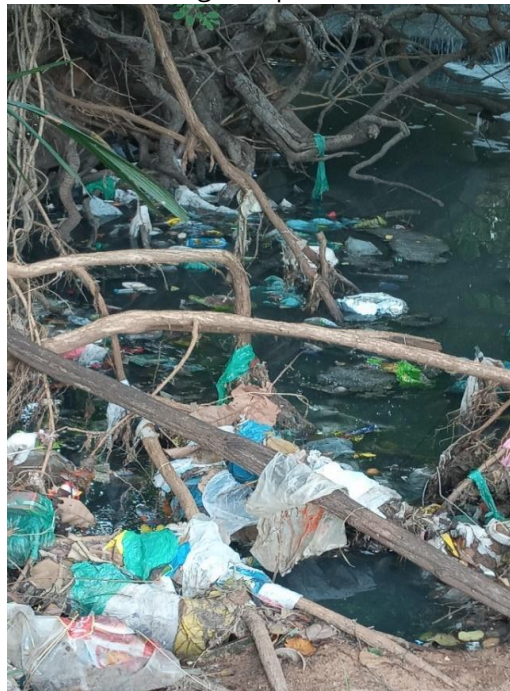
Figura 8 - Fluxo de água repleto de resíduos sólidos
