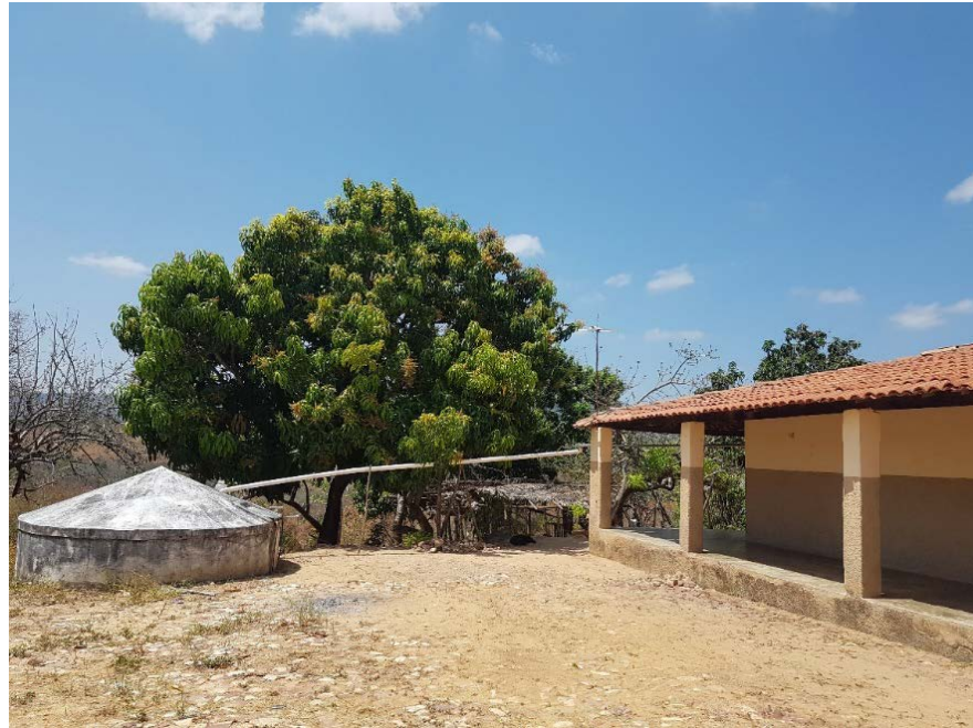
Figura 1 - Fotografia de cisterna no Distrito Arajara
