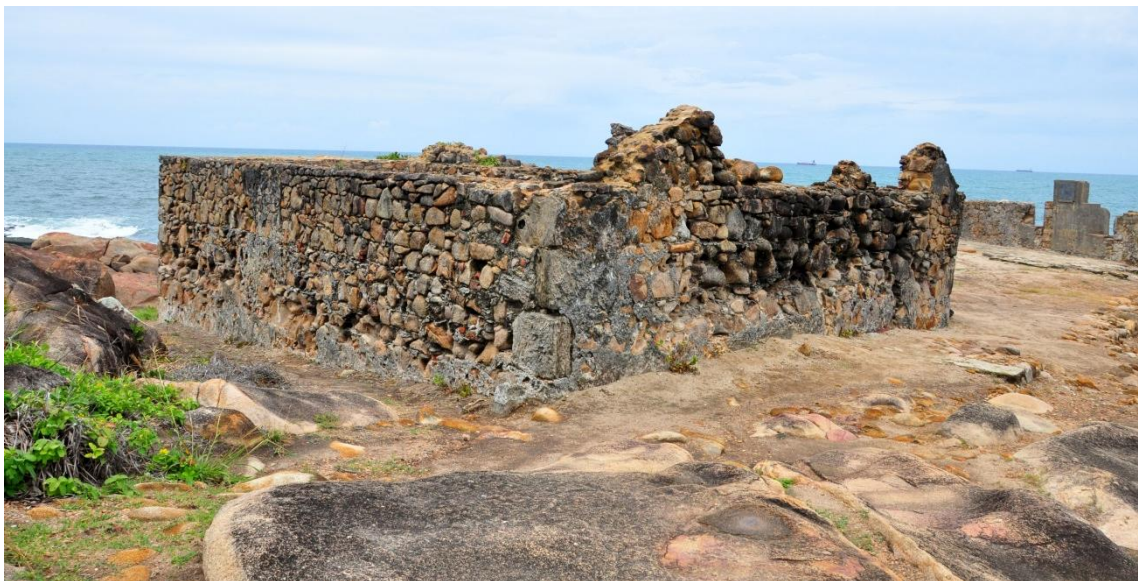
Figura 1: Ruínas do Forte Castelo do Mar (Séc. XVII) construídas basicamente com blocos graníticos provenientes do granito do Cabo e edificadas sobre o próprio afloramento - Cabo de Santo Agostinho (©Thaís Guimarães, 2014).
